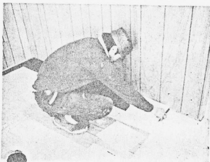
Cet ouvrier que nous avons surpris à l'ouvrage est, de l'avis même de M. Tremblay, un spécialiste de la pose des carreaux de préart. Son travail est minutieux, propre et bien fait.
